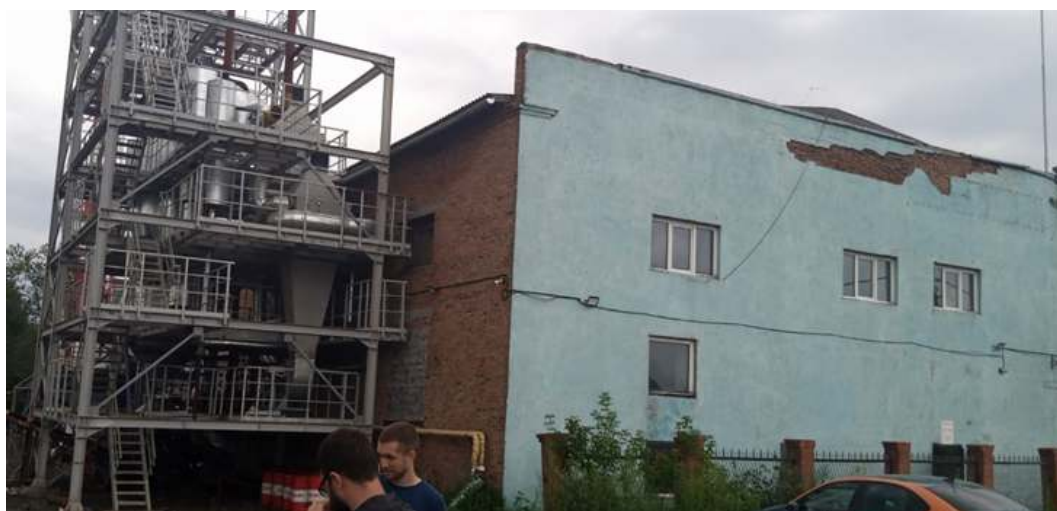
Рис. 1. Промышленный объект, на котором проводилось исследование
